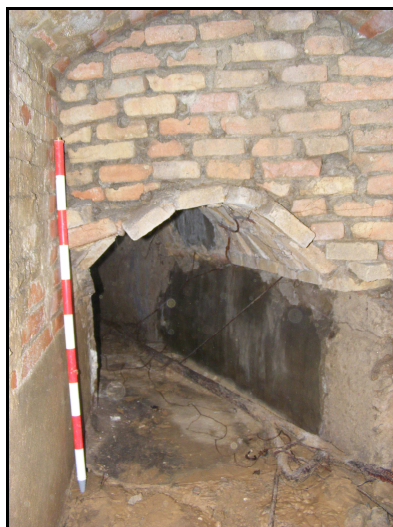
Fig. 25.- Detall de la UT 21 que es reblert per la ED 21.
