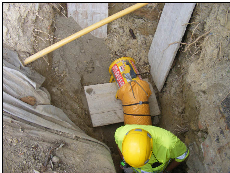
Fig. 17.- Detall de l'accés al col·lector.
