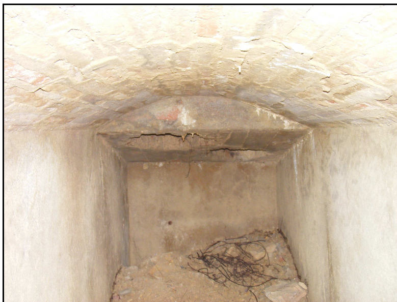
Fig. 23.- Detall dels desguassos afegits a la UT 21.
