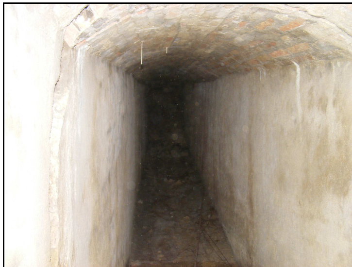
Fig. 20.- Vista general del Tram I de la galeria 2.
