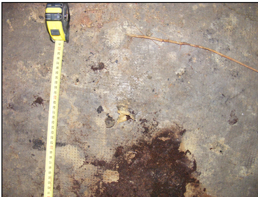
Fig. 16.- Detall del paviment (UP 12).
