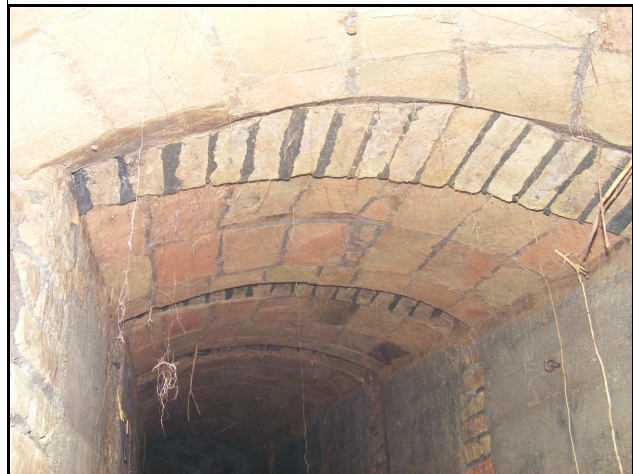
Fig. 14.- A l'esquerra, detall del mur (MR 15) que tapia la galeria en el tram IV. Fig. 15.- A sota, detall de les voltes i les arcades que coronen els pilars (PL 14-16).
